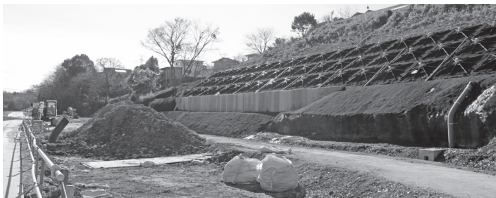
右側が施工中の南台第一工区。左奥が第二工区
